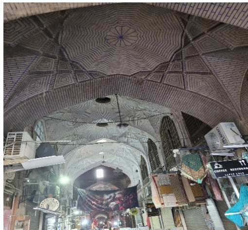
تصویر ۱۱ الف. هنر آجرکاری گره‌چینی سقف بازار قیصریه
